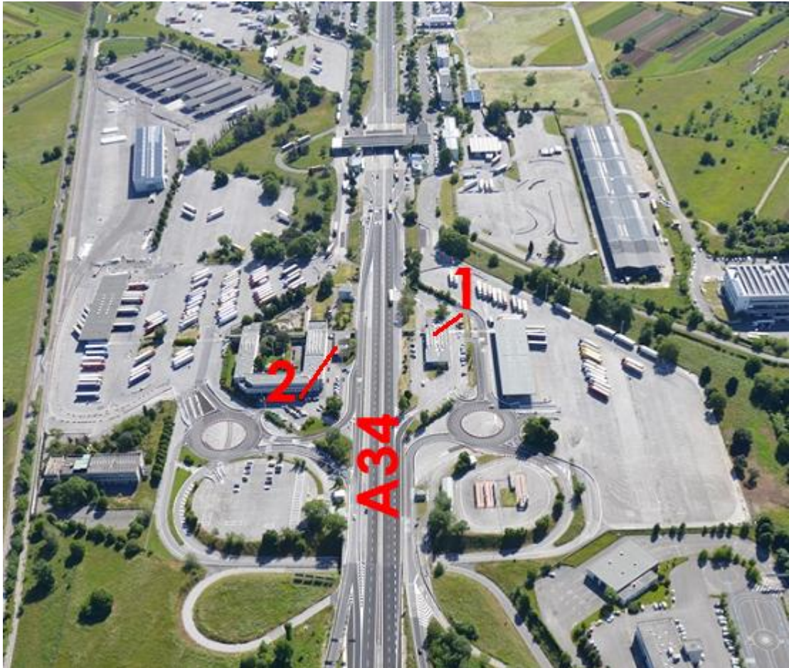
Slika 1 - Letalski posnetek mejnega prehoda Vrtojba z identifikacijo stavb, na katerih se opravijo dela
